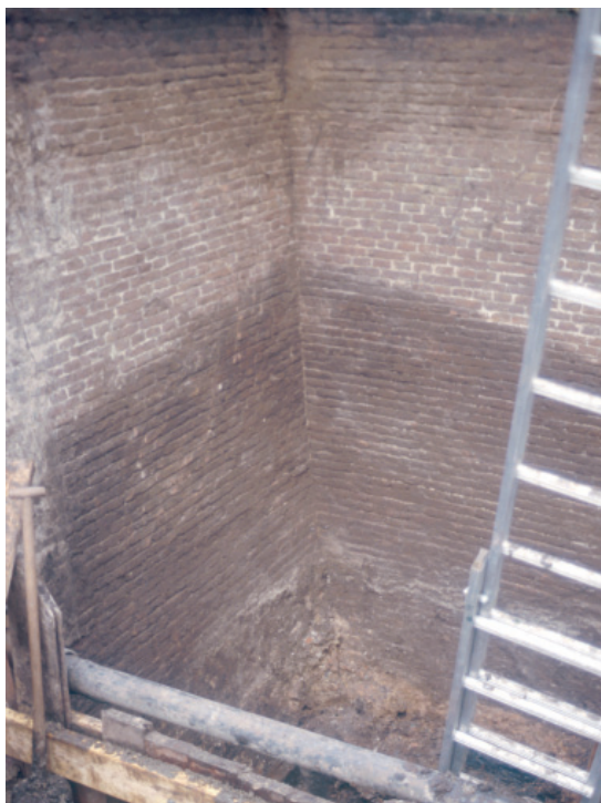
Afb. 10 Stadsmuur (links) en bastionmuur (rechts) in put III, richting noorden.
